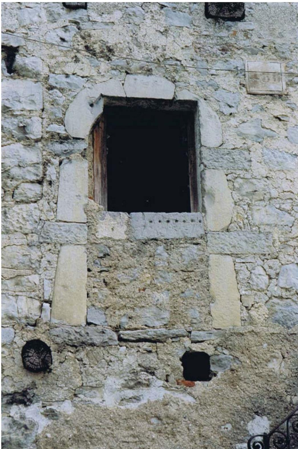
D'anciennes portes transformées en fenêtres. Les supports du balcon ont été sciés il y a déjà de multiples décennies, voire même des siècles. On en voit encore un bout fiché dans le mur et l'emplacement du second. Tout cela ne se remettra malheureusement jamais en place. Les supports du balcon supérieur de même ont été sciés tandis qu'on voit l'ancien numéro de la maison à droite de la fenêtre. Une façade qui raconte une longue histoire.
